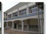
▲完成した体育館
